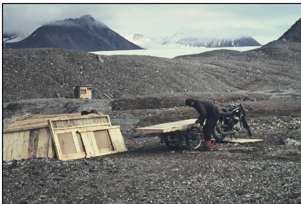
Ryc. 2. Budowa stacji wrocławskiej „Baranówki” w 1971 roku. Przedpole Lodowca Werenskiolda (fot. B. Głowicki)
